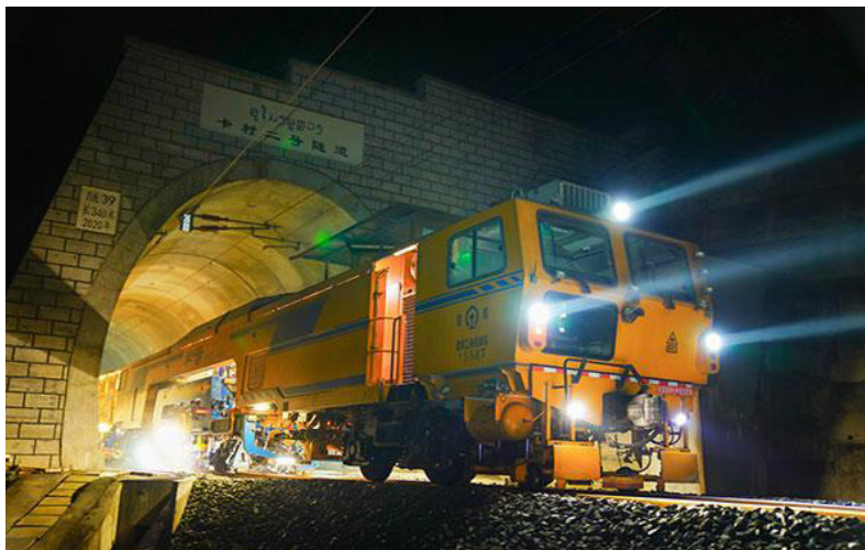
中老铁路琅勃拉邦维保管理中心的中老员工共同作业。
